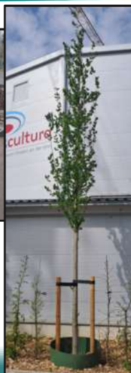
Einbau Pflanzsubstrat und Wurzelschutzfolie
