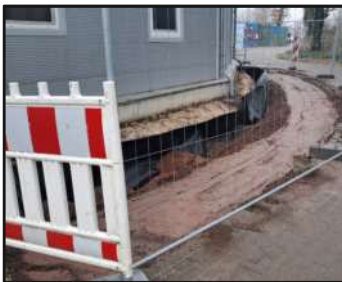
Einbau Pflanzsubstrat und Wurzelschutzfolie
